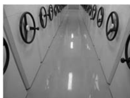
環氧樹脂(EPOXY)地坪
