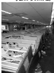
固定式檔案架防震連桿 (底部要固定)
