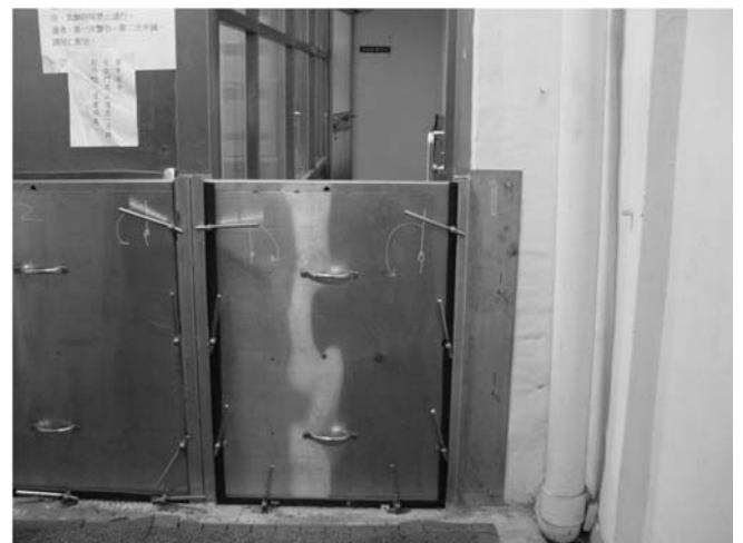
防水閘門(左圖：裝設前；右圖：裝設後)
