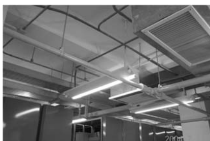
氣體式自動消防安全系統設備
