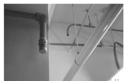
氣體式自動消防安全系統設備
