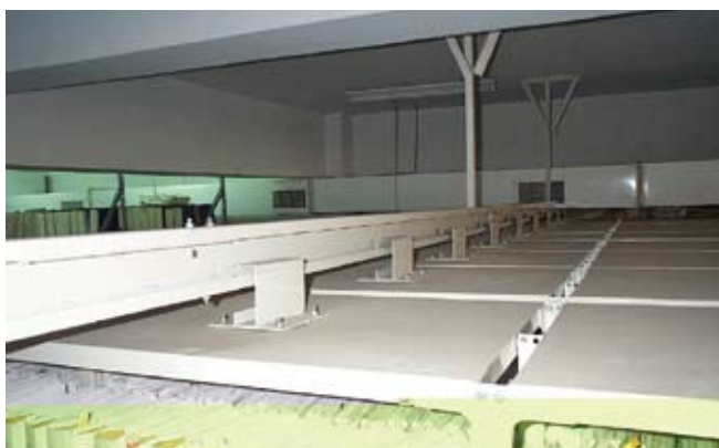
圖 66 密集式檔案架防震連桿 (二)
