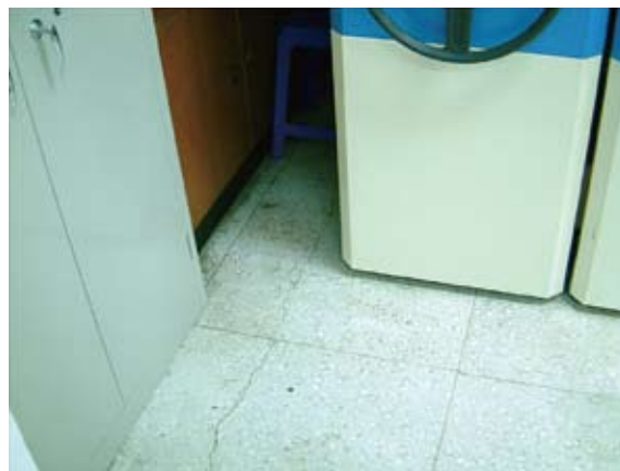
圖 19 地板超載產生裂縫之情形 ( 不良案例 )
