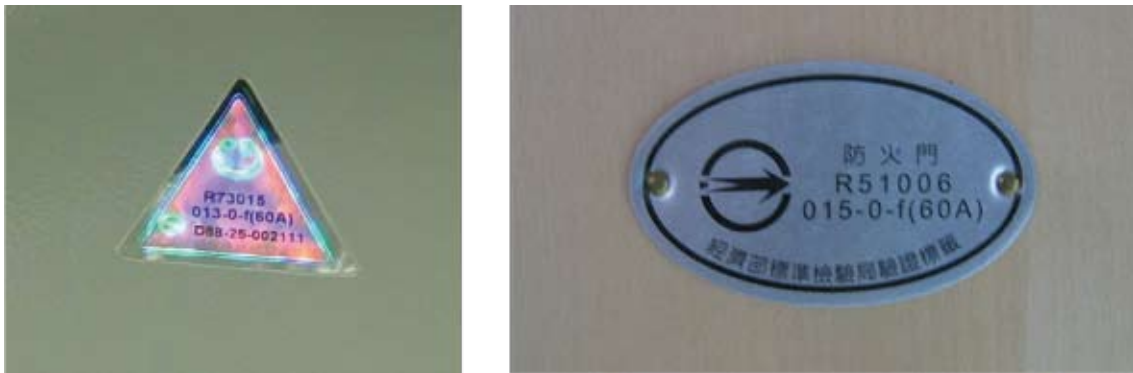
圖 12 1 小時以上防火時效「f(60A)」門窗的認證參考圖樣
