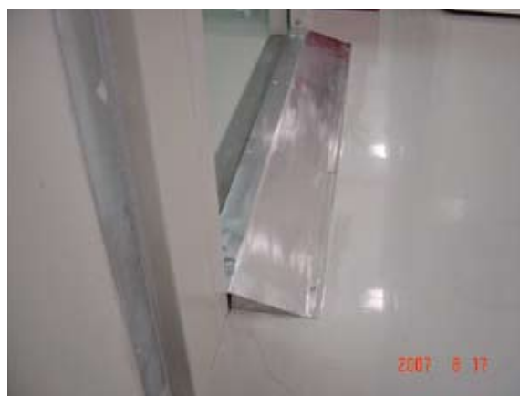
圖 18 不鏽鋼緩坡處理方式
