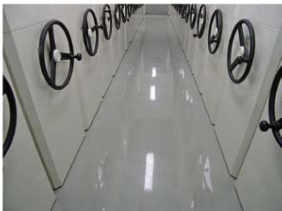
圖 15 環氧樹脂 (EPOXY) 地坪
