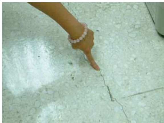
圖 19 地板超載產生裂縫之情形 ( 不良案例 )
