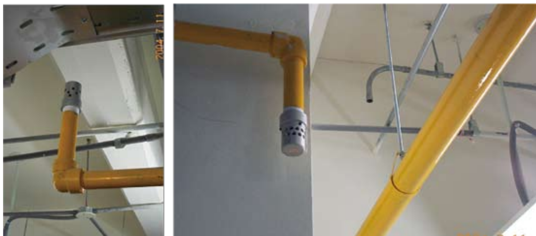
圖 48 自動氣體滅火系統噴頭
