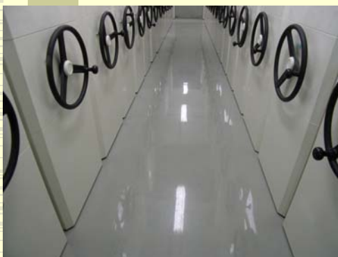
環氧樹脂(EPOXY)地坪
