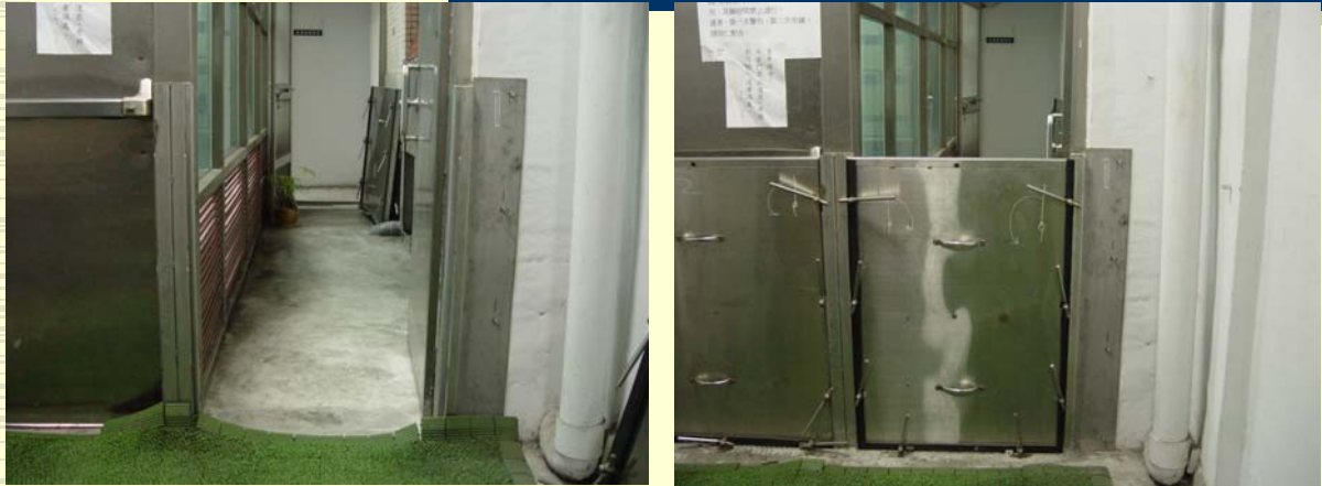
防水閘門(左圖：裝設前；右圖：裝設後)
