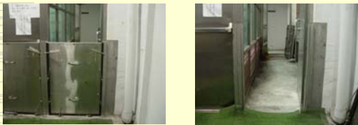
防水閘門(左圖：裝設前；右圖：裝設後)
