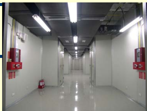
採用金屬庫板方式處理之分間牆案例
